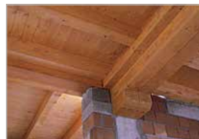
Recupero e consolidamento di solai in legno già esistenti Renovation and reinforcing of existing wooden floors
