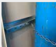
Catene di sicurezza per fissaggio bombole
