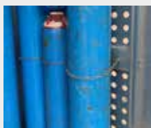
Catene di sicurezza per fissaggio bombole
