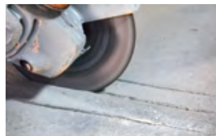
Creazione di tracce su cemento armato.
